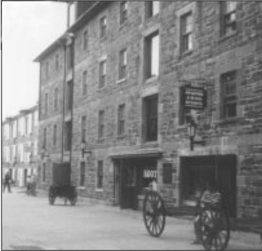
Figure 1. Construction en maçonnerie massive
